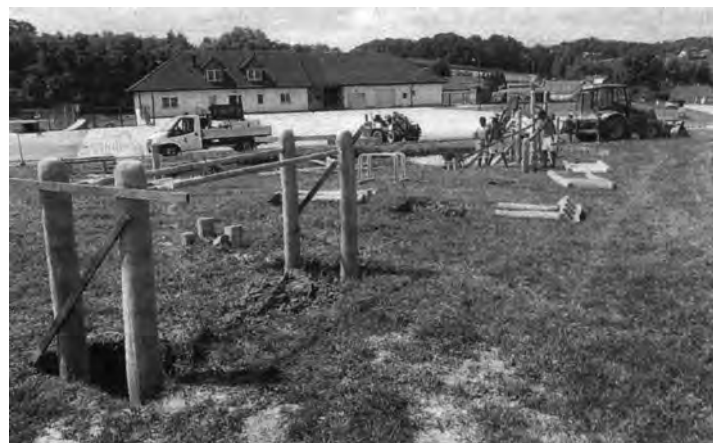
Seit Montag wird an dem Outdoor-Fitnesspark gebaut. In einem Monat soll alles fertig sein.
